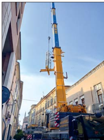
Una fase del montaggio della gru in via Mazzini con l'utilizzo di un'autogru di 70 metri
