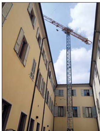
La gru di 40 metri montata nel cortile della Banca
